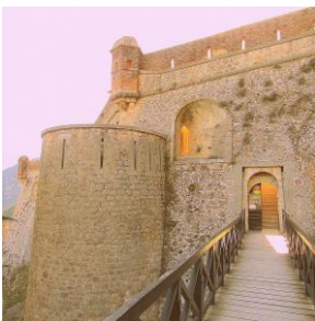
La passerelle et son pont-levis protégés par une tour ronde du fort Liberia
